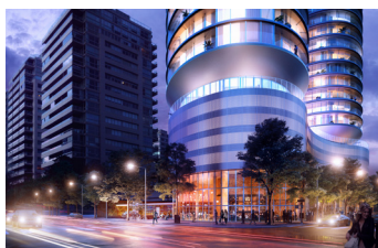
INFINITY TOWERS M2 de construcción: 44.772 m 2
